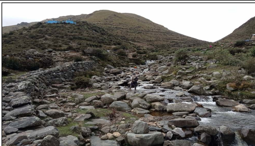
FIGURA N°01: TRAMO CRÍTICO EN EL RÍO MITUYACU, EN EL CENTRO POBLADO DE QUIO, DISTRITO DE CAYNA, PROVINCIA DE AMBO, REGIÓN HUÁNUCO, SE APRECIA QUE LA POBLACIÓN CONSTRUYÓ MUROS DE PIEDRA SIMPLEMENTE COLOCADO.
